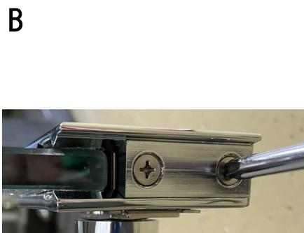
硝子に対して縦・横の位置を合わせたら、③押棒を交互に締め、本体を固定します。
