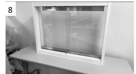
引戸を元に戻しプッシュロックがきちんと施錠できることを確認します。（確認後受穴プレートをハカマに圧着してください）
