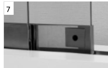
受穴プレートの養生シート、離型紙を剥がし、受穴プレートをテンプレートにはめて貼ります。
